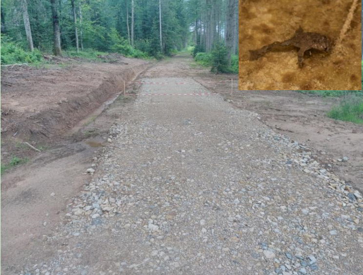
Ornière remblayée abritant auparavant des Sonneurs à ventre jaune.
